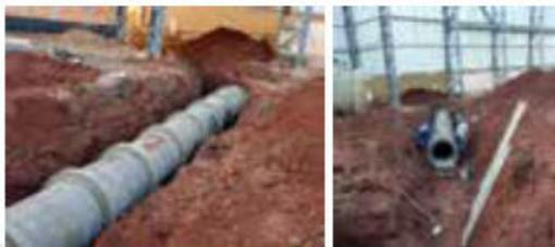
Situação que estava a antiga usina antes do início das obras, trabalho de instalação do novo telhado e a grande surpresa do projeto, muita água que obrigou a implementação de uma robusta estrutura de drenagem de água pluvial
