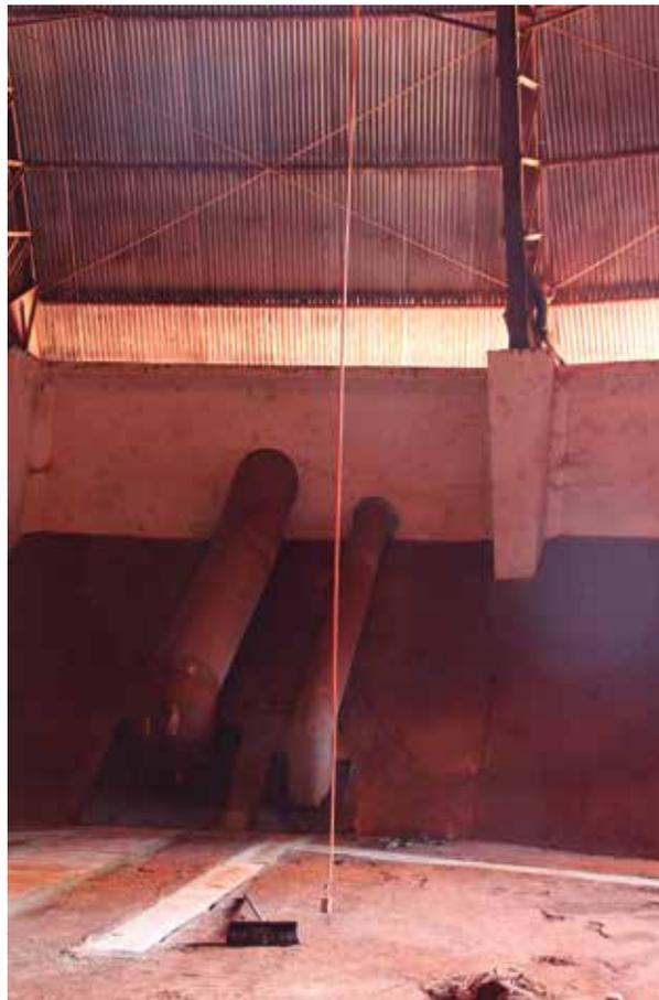
*Um dos sensores instalados na cúpula de Guaira: equipamento mede a temperatura do grão e, em caso de ultrapassar o permitido, aciona automaticamente o sistema de ventilação*
