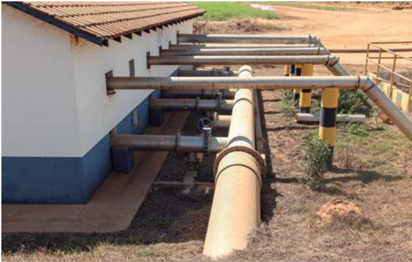
Sistema de mistura de água e vinhaça
