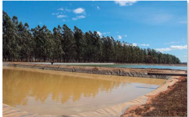
Tanque de vinhaça e água
