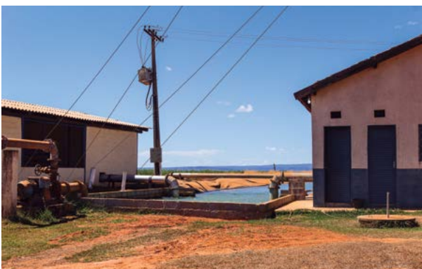
Unidades que bombeiam para a estrutura de pivô e gotejamento
