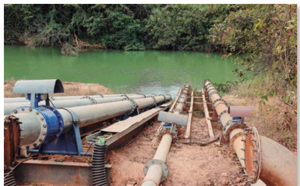
Sistema de captação da água
