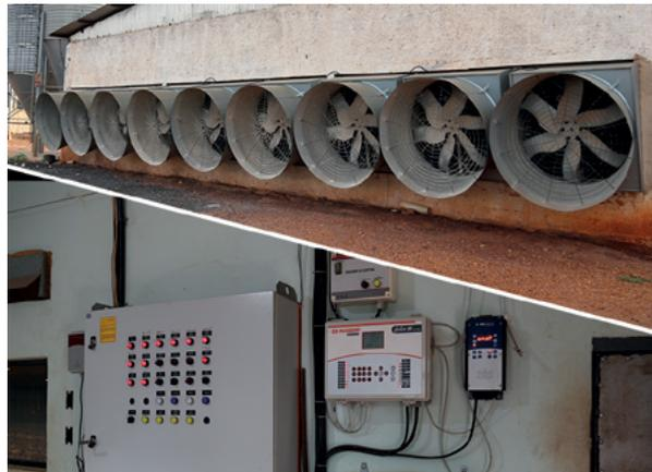
Estrutura de exaustores que controlam a temperatura no interior da granja num sistema de pressão negativa e o seu painel de controle
