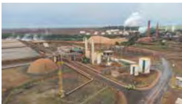
Planta de biogás, do Bioparque Bonfim, voltada para a produção de energia elétrica (o biogás utiliza a torta de filtro e a vinhaça como matéria-prima, resíduos da operação agroindustrial da cana-de-açúcar)
